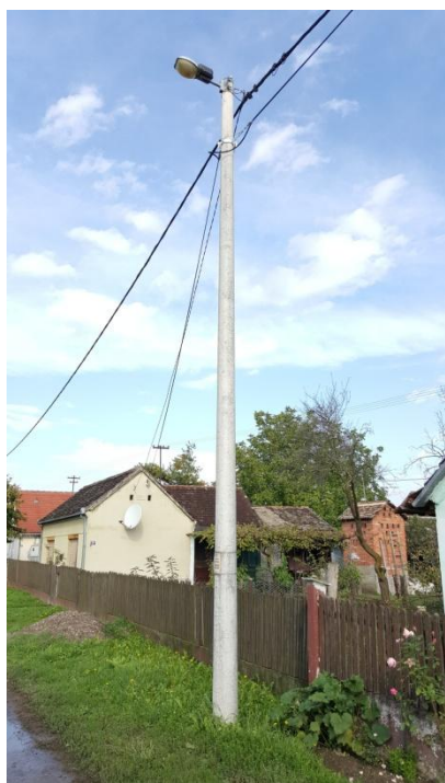
Strošinci – svjetiljka na betonskom stupu NN mreže
